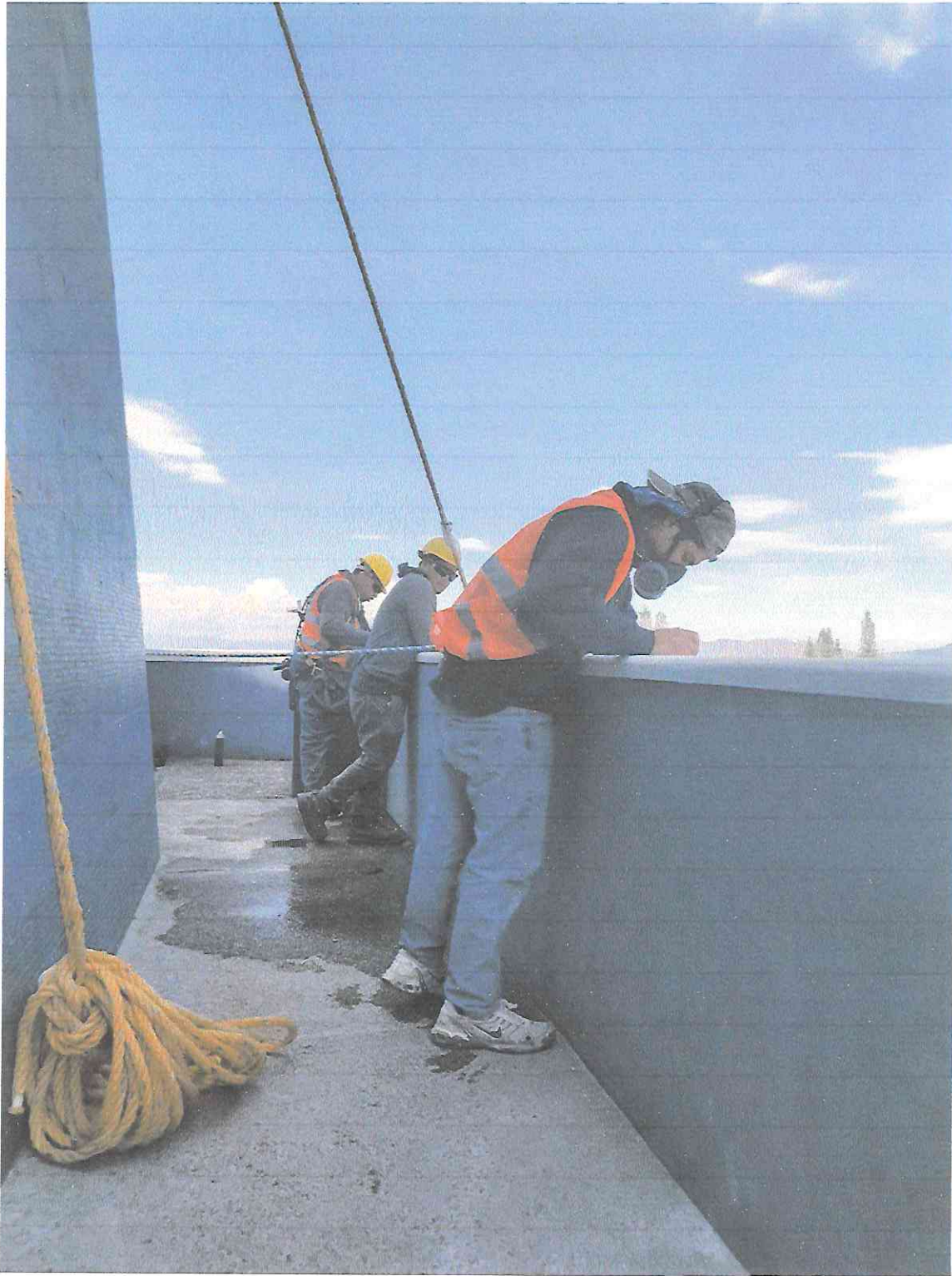
Limpieza y desinfección de teselas en segmento B1 de fachada Oriente.
